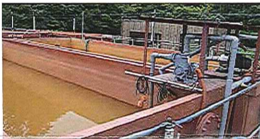
油汚染土壌浄化
