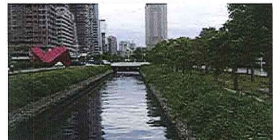
新光路排水明渠水質改善(台湾・高雄市)
