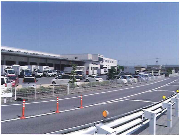
岡山県・倉敷近郊 食品工場
