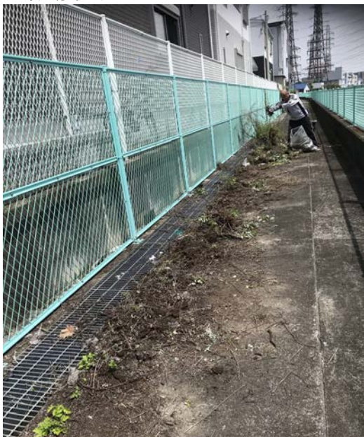
・管理用通路の草刈り及びゴミの回収作業
